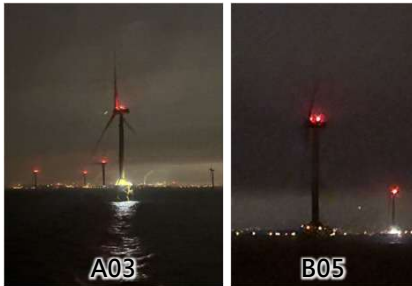
航空警示燈設置照片
