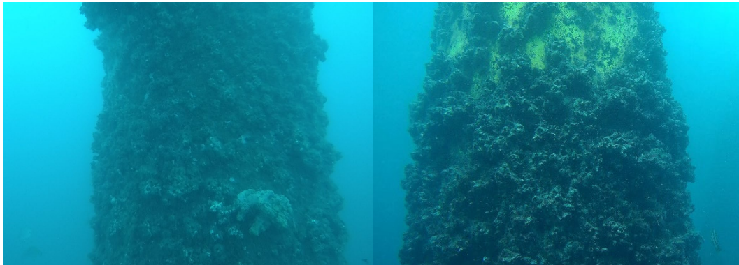
圖 2.1.8-1 D01 基樁表面生長軟珊瑚、藤壺照
