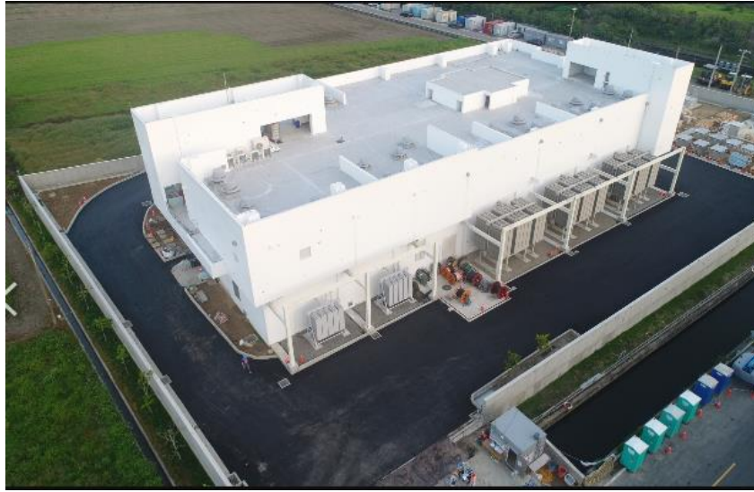
自設升壓站空景，拍攝日期：110年6月9日
