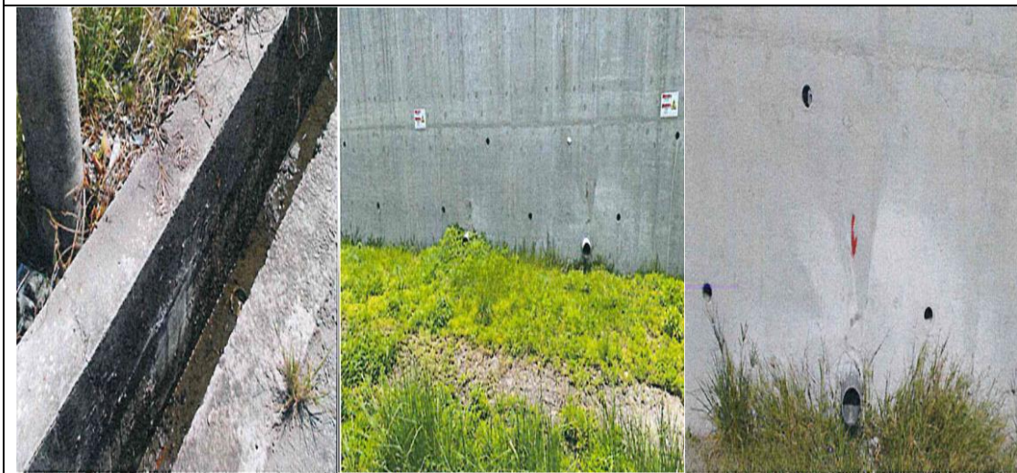
工區放流口，拍攝日期：111 年 4 月 25 日、5 月 3 日、6 月 23 日
