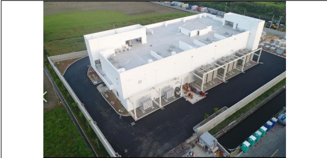
自設升壓站空景，拍攝日期：110 年 6 月 9 日
