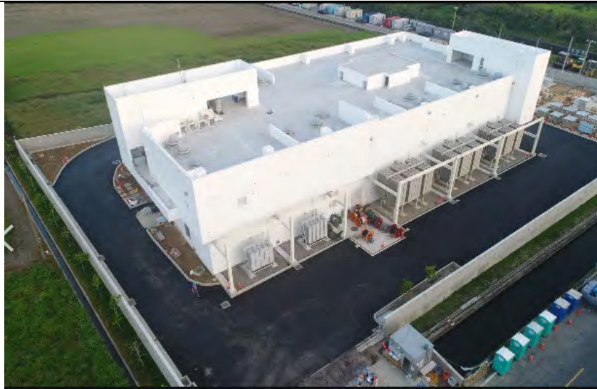
自設升壓站空景，拍攝日期：110 年 6 月 9 日
