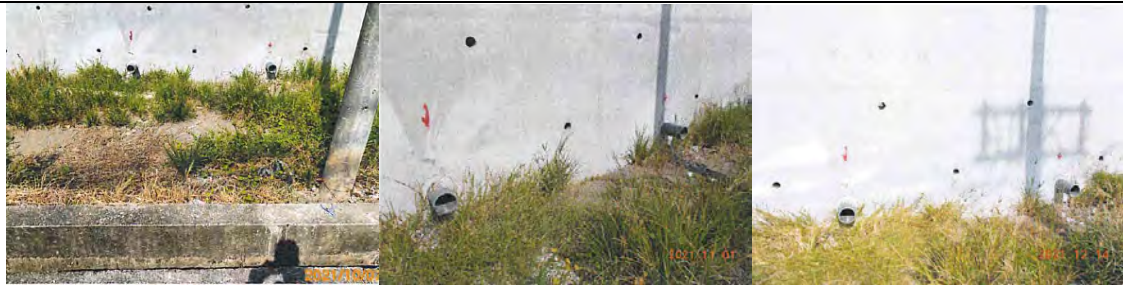
工區放流口，拍攝日期：110 年 10 月 7 日、11 月 1 日、12 月 14 日
